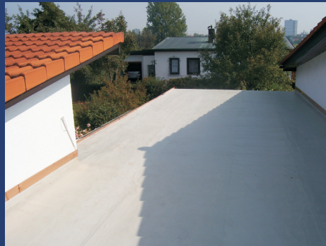
Garagenabdichtung mit Flüssigkunststoff
