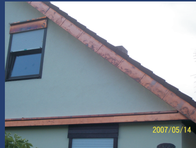
Ortgang- und Gesimsverkleidung aus Kupfer
