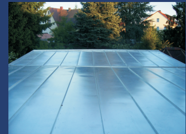
Metalldachdeckung aus Uginox FTE (Edelstahlverzinnt)
