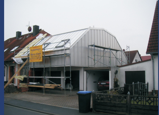
Verkleidung aus Uginox FTE (Edelstahlverzinnt)
