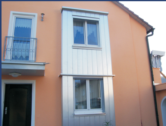
Verkleidungen des Vorbaus und Eingangüberdachung aus Uginox FTE (Edelstahlverzinnt)
