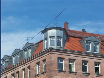
Gaubenverkleidung aus Titanzink
